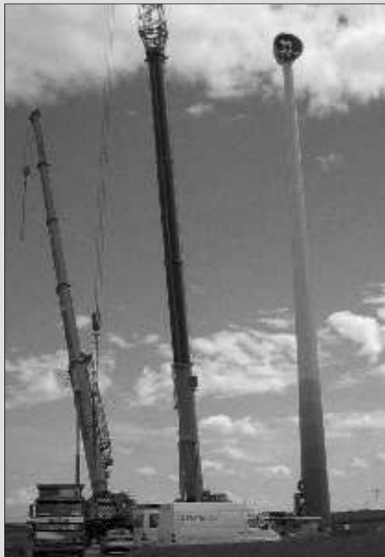
Seit dem 1. Jahrtausend v. Chr. waren Windkraftanlagen bekannt, die mechanisch Mühlsteine antrieben. Wind ist ein erneuerbarer Energieträger und er hinterlässt auch keinerlei Schadstoffe. Energie in Form von Strom aus Windkraftanlagen zu erzeugen, wird durch die moderne Technik immer interessanter. Technische Daten einer 600 kW Anlage: Rotordurchmesser: 40m, Nabenhöhe: 60m.
