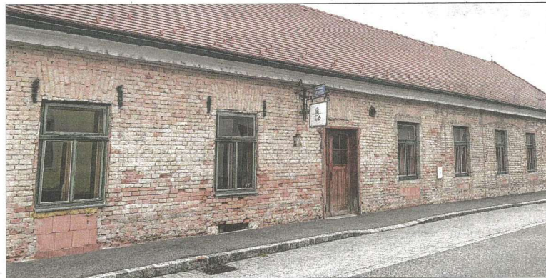
Im Zuge der bevorstehenden Renovierungsarbeiten soll laut VP-Bürgermeister Otto Auer auch die Fassade des Gasthauses erneuert werden.
