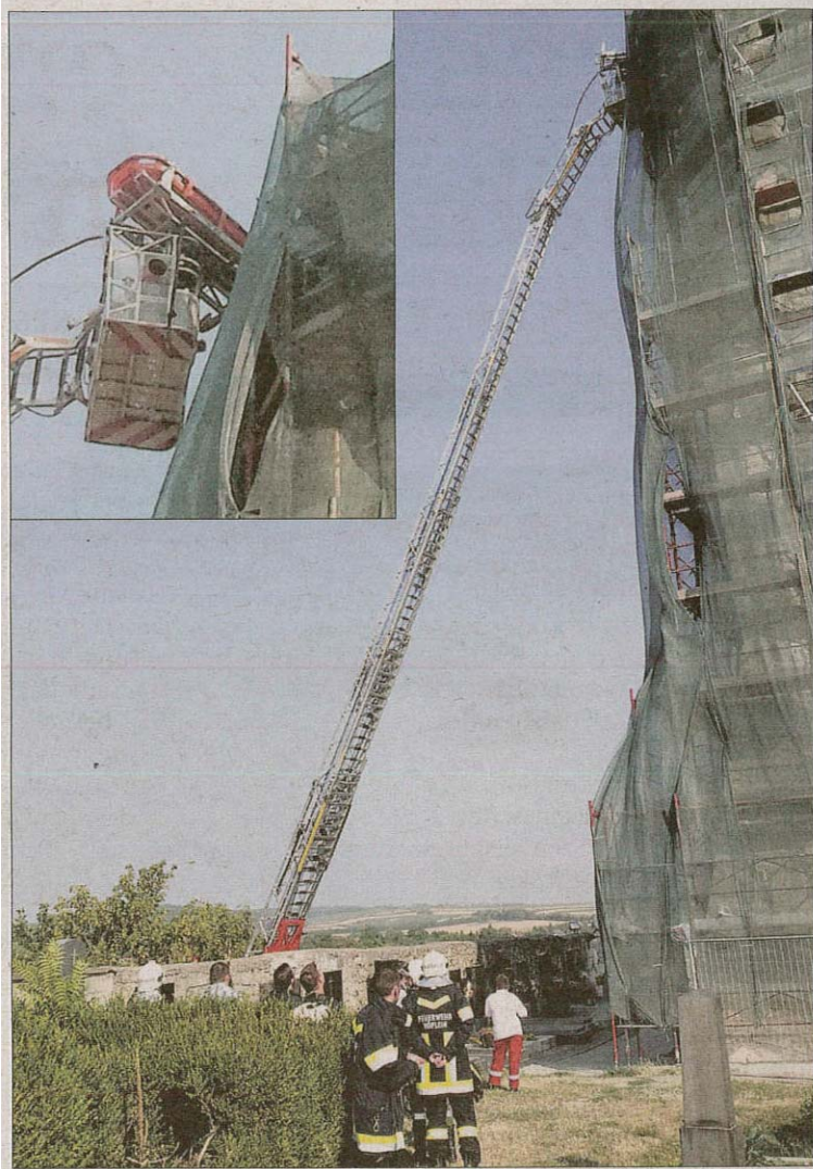
Die Wehren aus Höflein und Bruck brachten den Arbeiter aus luftiger Höhe in Sicherheit.
