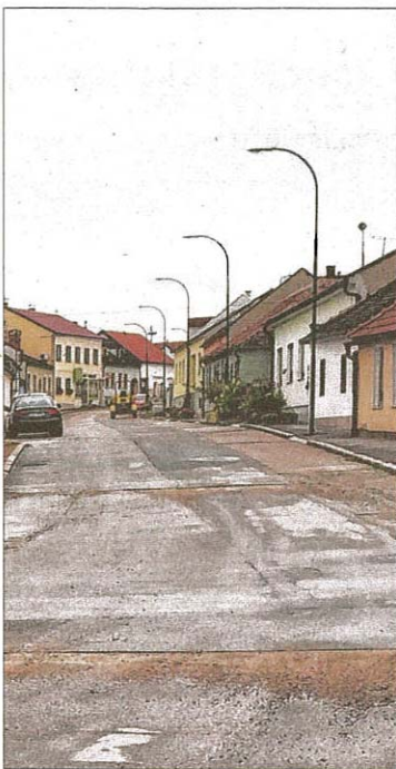
Die Vohburgerstraße wird nun zur Einbahn umgebaut. Foto: Archiv
