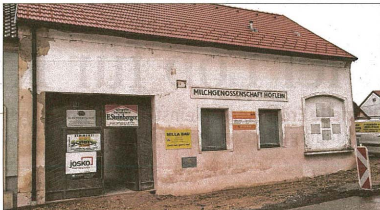
Die Generalsanierung des Milchhauses ist bereits weit gediehen. Foto: Kirchhauer
