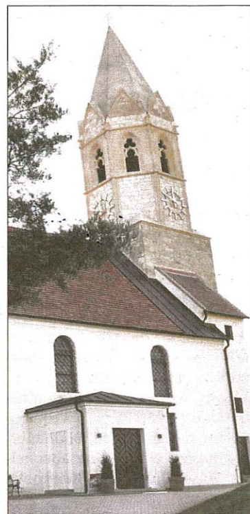
Der Höfleiner Kirchturm wurde saniert.
