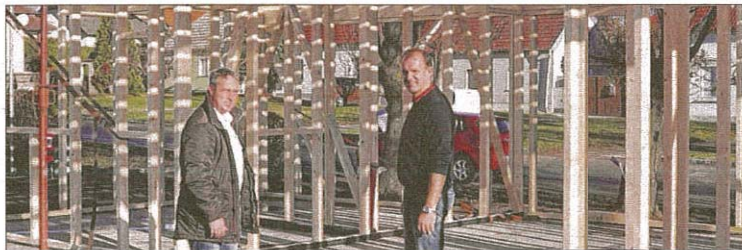
Gemeinderat Wolfgang Pinter und Bürgermeister Otto Auer vor der Holzkonstruktion der neuen Teichkantine.
