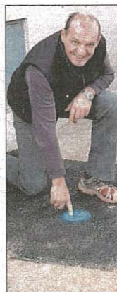
Bürgermeister Otto Auer bei der aufgegrabenen Asphaltfläche. Foto: Puchegger
