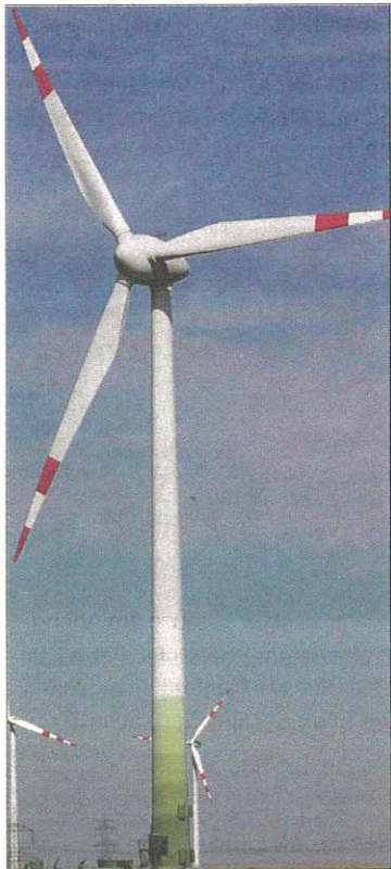
Mit der Fertigstellung des Windparks West wird die Zahl der Windräder auf Höfleiner Gemeindegebiet auf 33 erhöht. Symbolfoto: Burggraf
