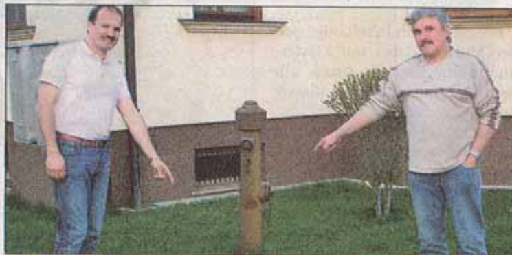
Bürgermeister Otto Auer und Helmut Weidlich zeigen auf eine der Stellen, wo sich ein leckes Wasserrohr befindet.
