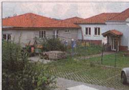
Der dritte Flügel des Kindergarten-Gebäudes steht - plangemäß - schon kurz vor der Fertigstellung.
