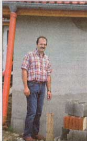
Bürgermeister Otto Auer auf der Baustelle vor dem Kindergarten.
