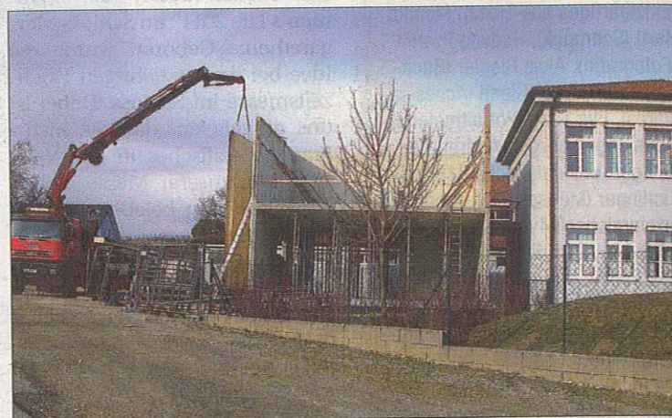
Mit Hilfe eines Kranwagens stellte die Firma Schäfer am Montagvormittag die Holzriegelwände des Zubaus zur Schule auf. FOTO: TS
