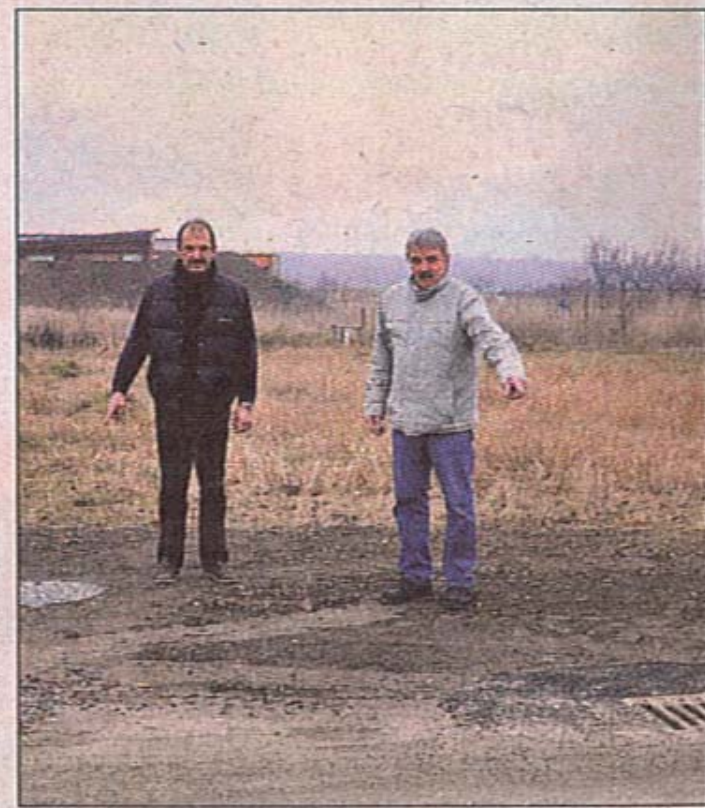
Otto Auer bei der Kanalerweiterung in der Feldgasse. FOTO: ZVG
