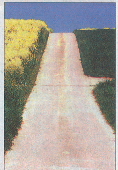
Künftig sollen die Güterwege der Gemeinde sukzessive asphaltiert werden. Foto: Waldhäusl
